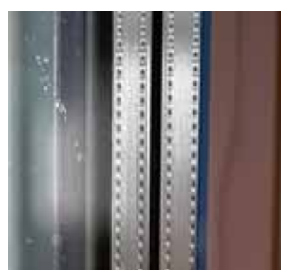
Um die Wärme im Haus zu halten, sind die Fenster dreifach verglast.
