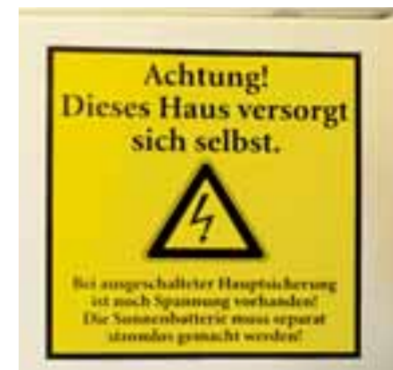
Auch wenn der Strom ausfällt, ist dank eines Batteriespeichers genug da.
