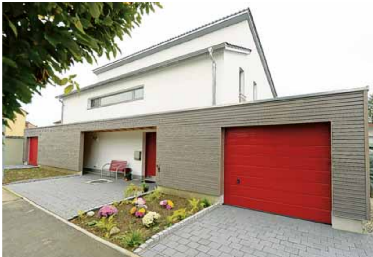
Das Haus der Familie Lechner richtet sich nach der Sonne: Auf der Nordseite, die unser Bild zeigt, hat es nur ein kleines Fensterband, im Süden dafür eine Front mit großen Fenstern. Fotos: Bernhard Weizenegger
